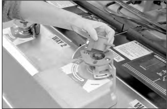
Figura 101. Quite la llave de bloqueo mecánico.
