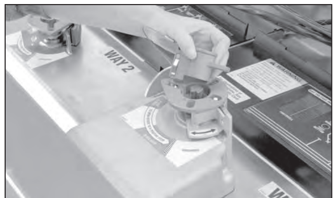
Figura 126. Inserte la llave de bloqueo mecánico.
