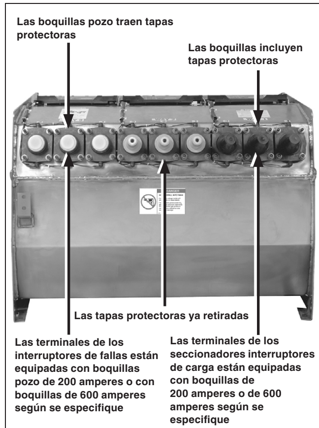
Figura 75. Tanque del interruptor Vista con tapas protectoras. (Se muestra la unidad manual con fines ilustrativos).
