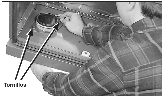
Figura 116. Instale el conjunto en el paso para cables y asegúrelo.
