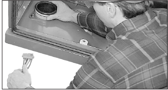
Figura 57. Canalice los cables por el paso.
