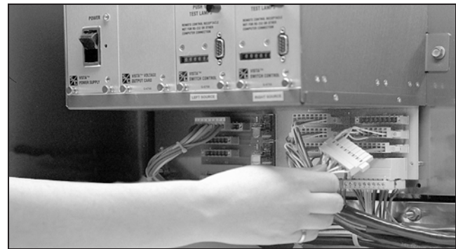
Figura 24. Fije los conectores.
