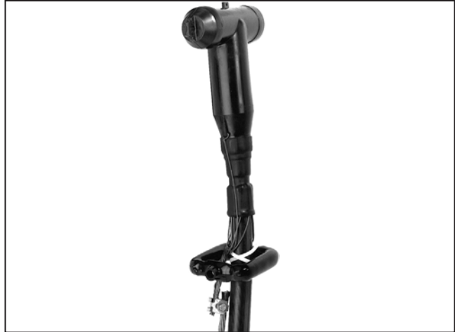
Figura 51. Sensores de corriente colocados alrededor del neutro concéntrico aterrizado del cable.
