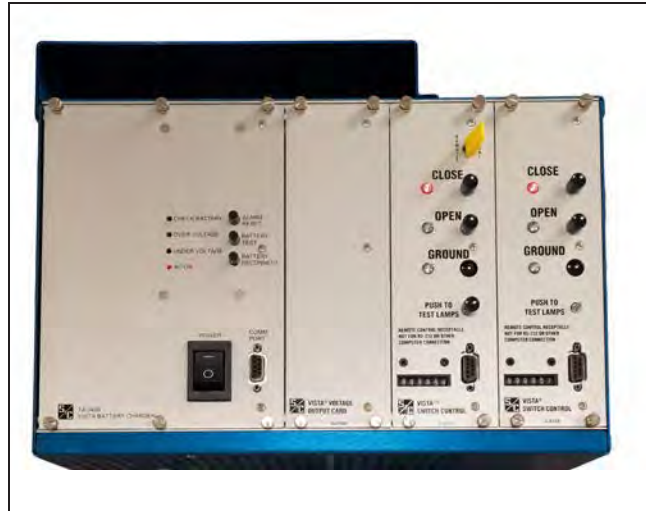
Figura 69. La indicación de Abrir en el tablero de control del motor coincide con la posición del moto operador.
