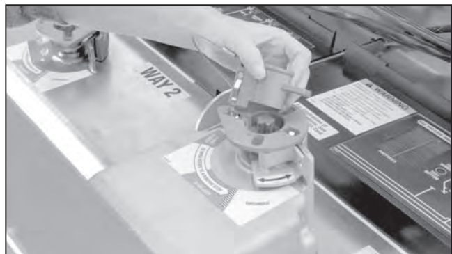
Figura 66. Inserte la llave de bloqueo mecánico.
