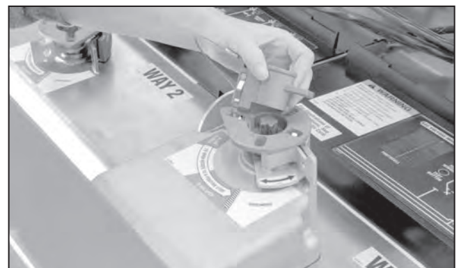
Figura 96. Inserte la llave de bloqueo mecánico.
