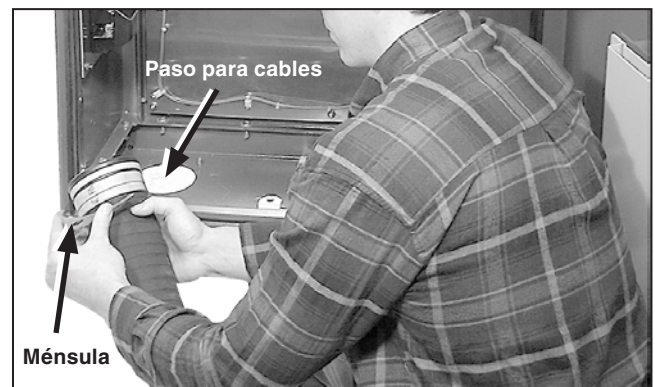
Figura 55. Coloque las ménsulas de soporte en el canal ranurado del conducto.
