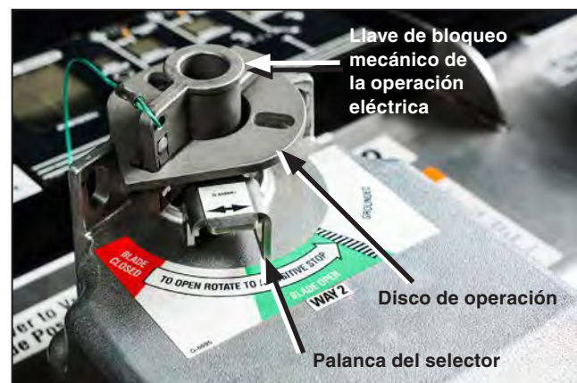
Figura 36. Indicación de la posición de CERRADO del moto operador.
