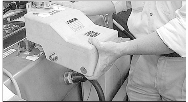
Figura 30. Coloque el moto operador sobre el eje de operación del equipo.
