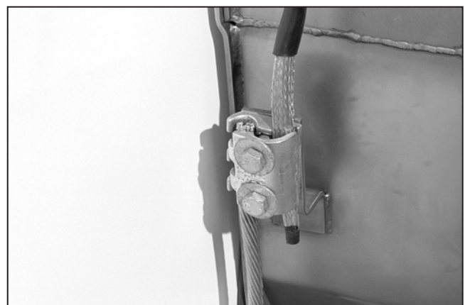
Figura 79. Conecte el cable con capa protectora a la tierra del tanque.
