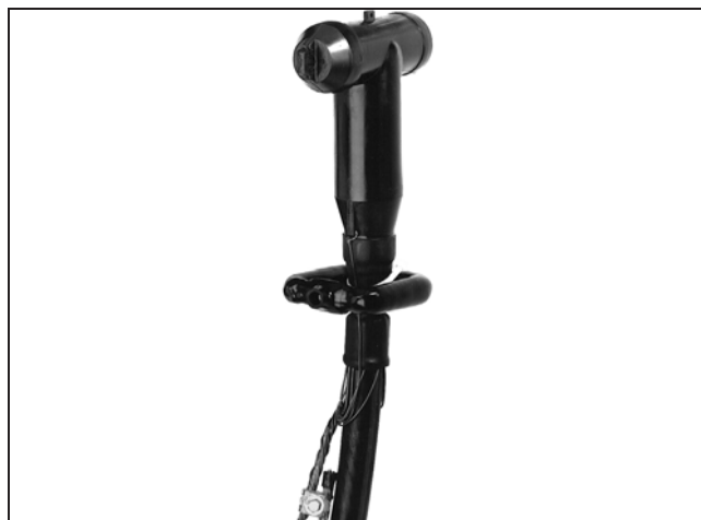
Figura 16. Sensores de corriente colocados por encima del neutro concéntrico aterrizado del cable.
