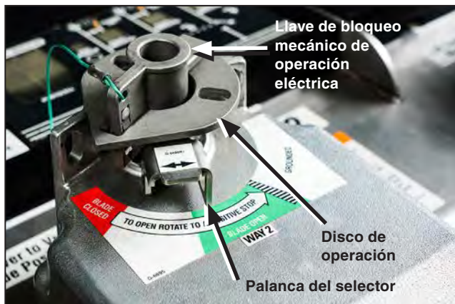
Figura 129. La indicación de posición Cerrado en el moto operador.
