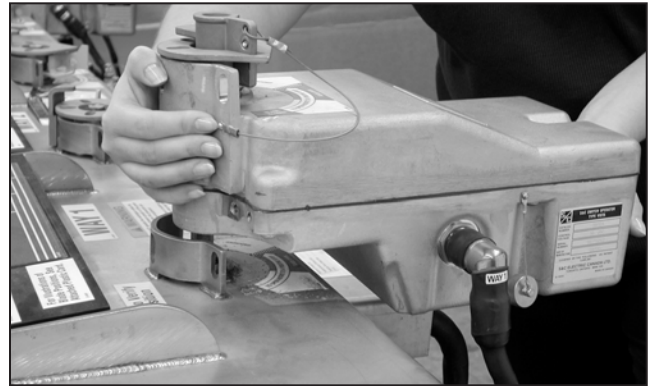
Figura 123. Coloque el moto operador sobre el eje de operación del equipo.
