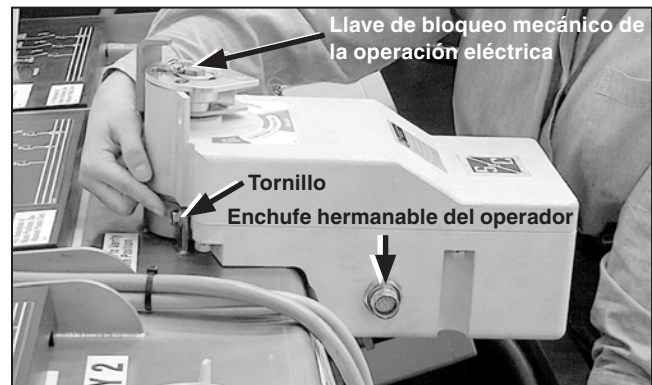
Figura 65. Conecte el cable del moto operador al enchufe hermanable del operador.
