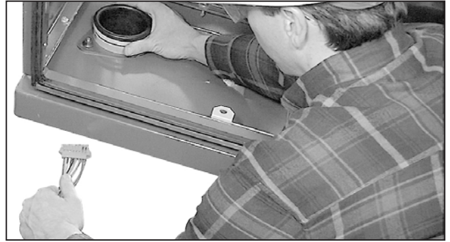
Figura 117. Canalice los cables a través del paso del cable.
