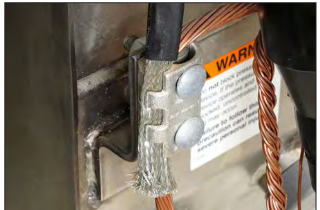
Figura 109. Conecte el cable con capa protectora a la tierra del tanque.
