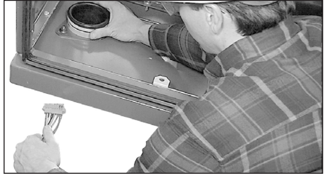
Figura 87. Canalice los cables por el paso de cables.
