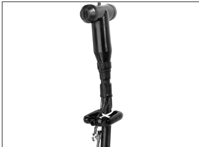
Figura 15. Sensores de corriente colocados alrededor del neutro concéntrico del cable aterrizado.
