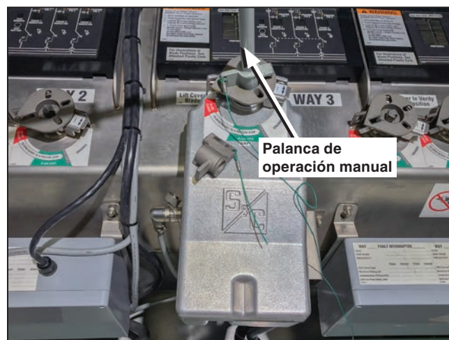
Figura 29. Retirar la palanca de operación.
