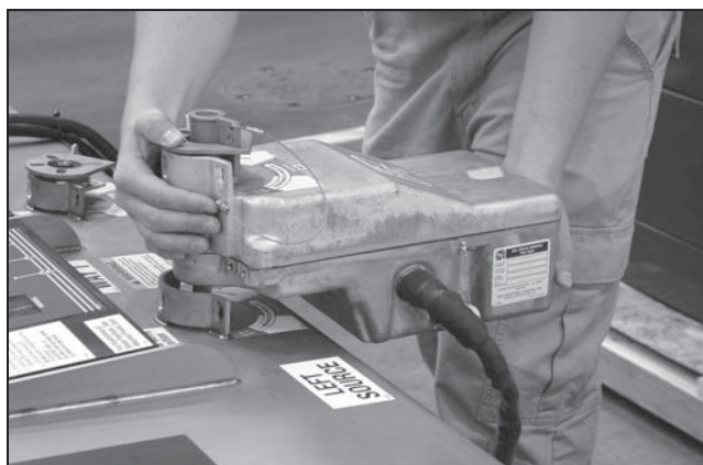
Figura 36. Ice el moto operador.
