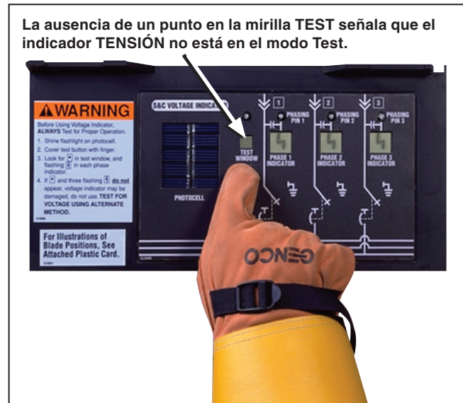
Figura 45. Asegúrese de que haya suficiente luz para ejecutar el sistema de auto prueba y el botón TEST esté completamente cubierto por un dedo dentro de un guante.
