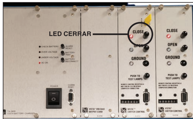
Figura 28. El indicador de la posición Close en el tablero de control del motor coincide con la posición del moto operador.
