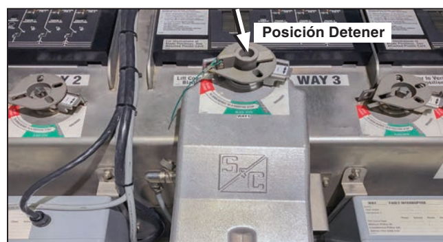
Figura 30. Vuelva a colocar la llave de bloqueo mecánico de operación eléctrica.
