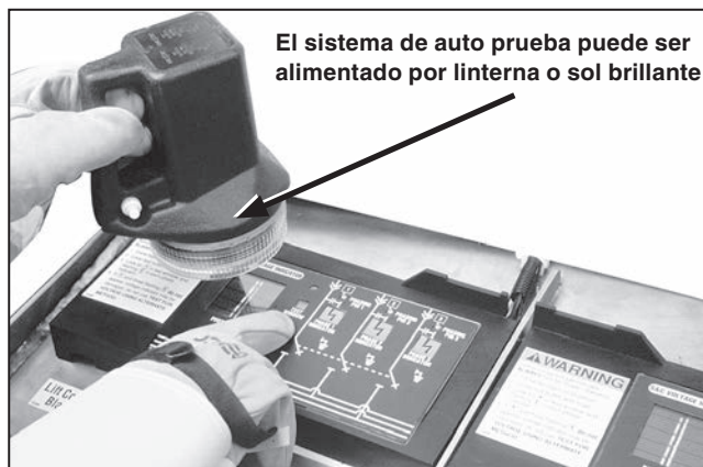
Figura 43. Colocar un dedo dentro del guante encima del botón TEST para iniciar la prueba.
