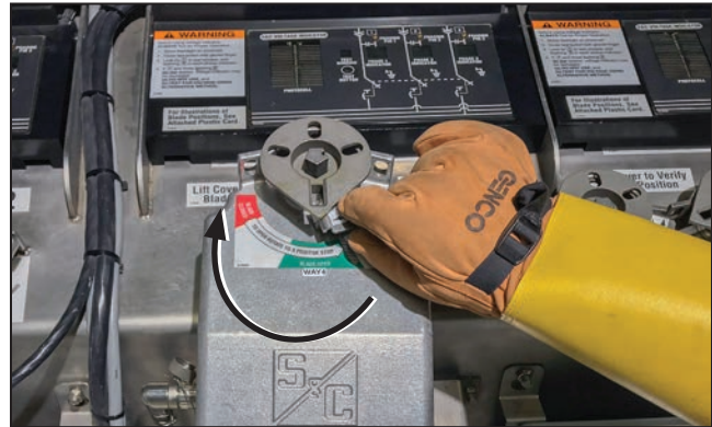
Figura 20. Girando el selector de operación a la extrema izquierda habilita la operación a la posición Aterrizado.
