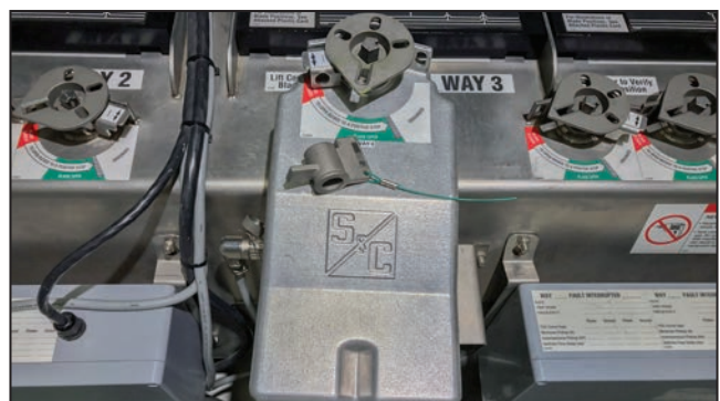
Figura 33. En la posición extrema izquierda, el selector de operación permite la operación entre las posiciones Abierto y Aterrizado.
