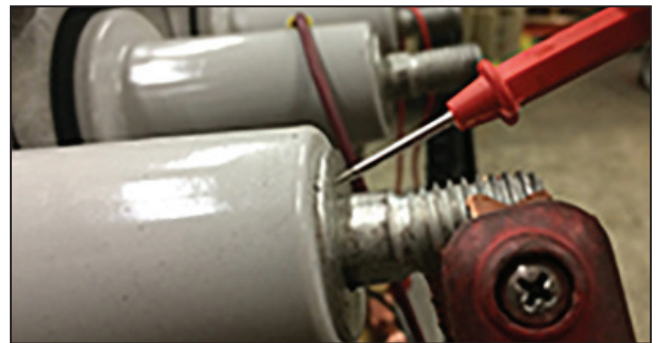
Figura 57. Tome la medida desde la superficie plana que lleva la corriente de la boquilla.●
