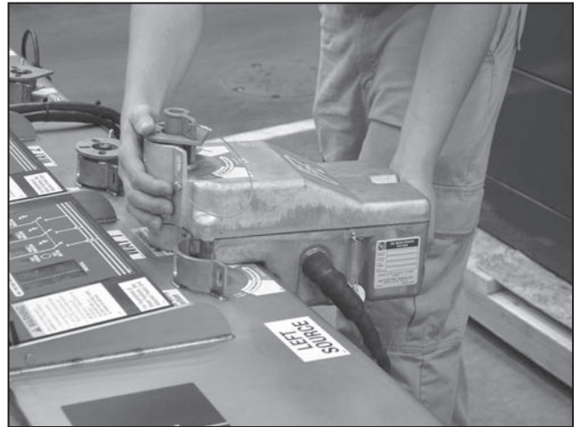
Figura 38. Vuelva a colocar el moto operador.
