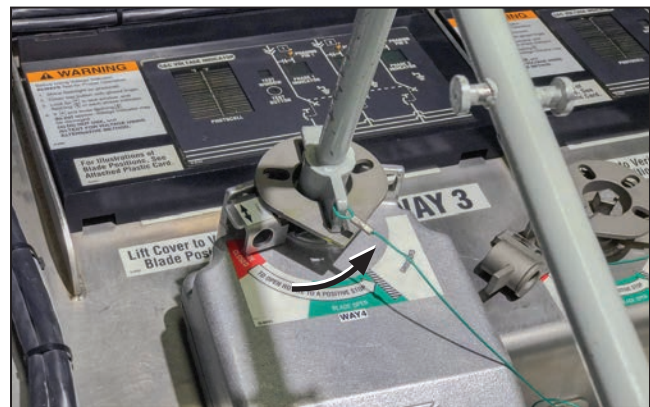
Figura 21. Conectando a tierra el seccionador interruptor de carga (o interruptor de fallas).
