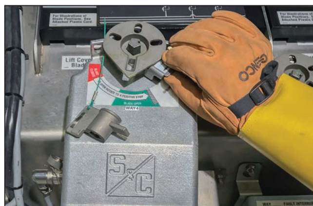
Figura 15. Gire el selector de operación fuera de la vía.
