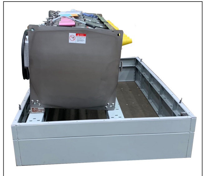
Figura 13. Mantenha o tanque preso aos trilhos de suporte. O tanque e os espaçadores da base são projetados para ser içados como uma unidade única.
