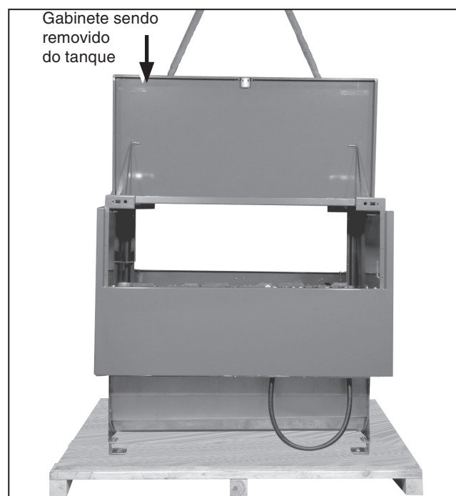
Figura 11. Desparafuse o gabinete e remova-o do paletão.
