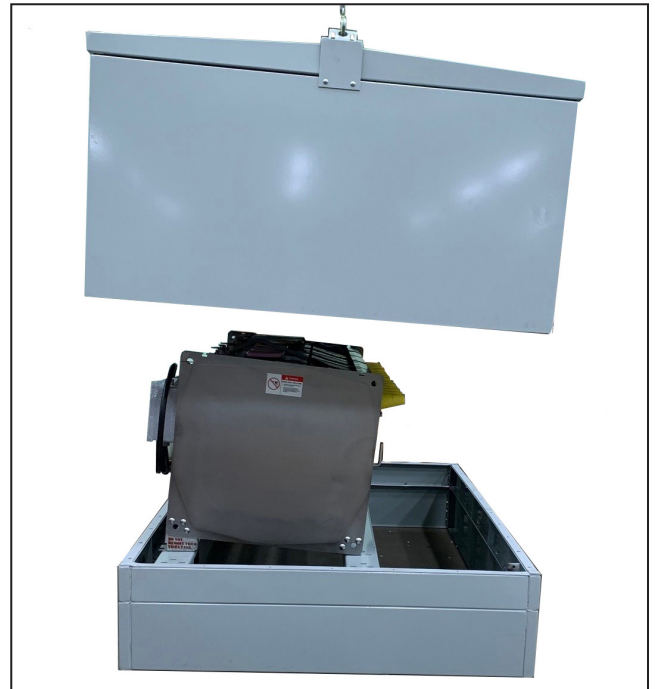
Figura 12. Remova o compartimento dos espaçadores da base.
