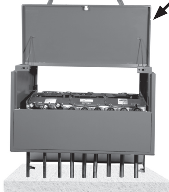
Figura 17. Abaixe o gabinete e posicione-o sobre os furos dos chumbadores.
