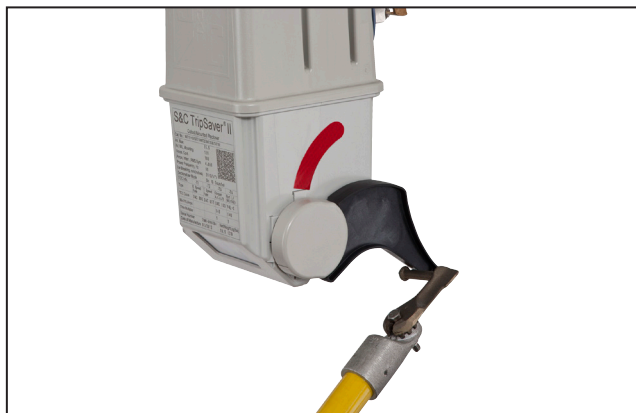
Figura 10. Posicione o cabeçote abaixo da alavanca e levante para estabelecer o modo Auto.
