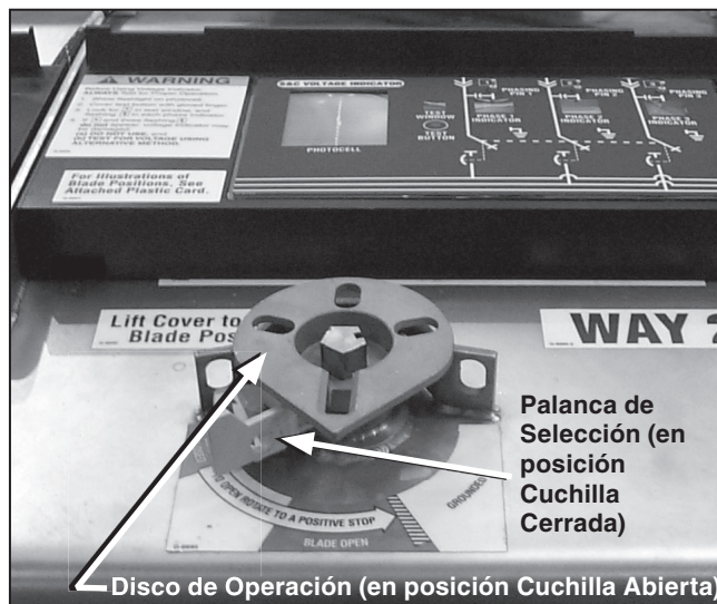
Figura 2. Palanca de Selección en la posición Cuchilla Cerrada.
