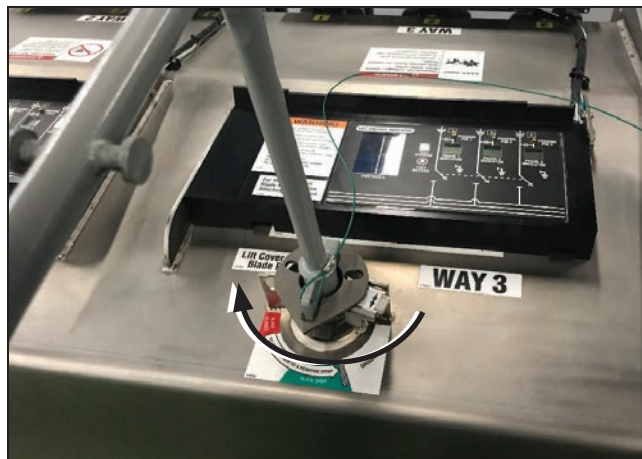
Figura 21. Fechamento do interruptor de carga ou do interruptor de falta.
