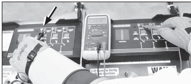
Figura 41. Medição da tensão fase-fase—Fase 1 para Fase 1.
