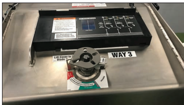
Figura 22. Interruptor de carga ou interruptor de falta na posição Fechada.
