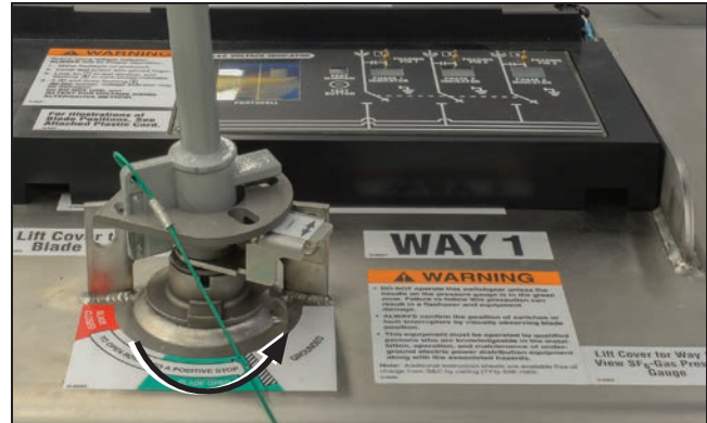
Figura 23. Gire a alavanca de operação em sentido anti-horário até a posição Aberta.
