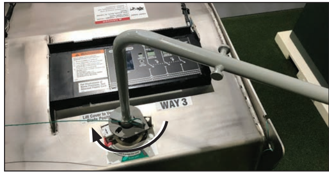
Figura 19. Operação da Posição Aterrada para a Posição Aberta.
