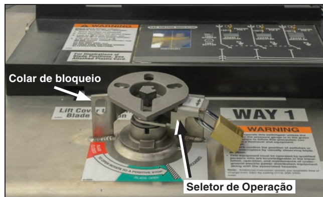
Figura 26. Bloqueio na posição Aterrada.
