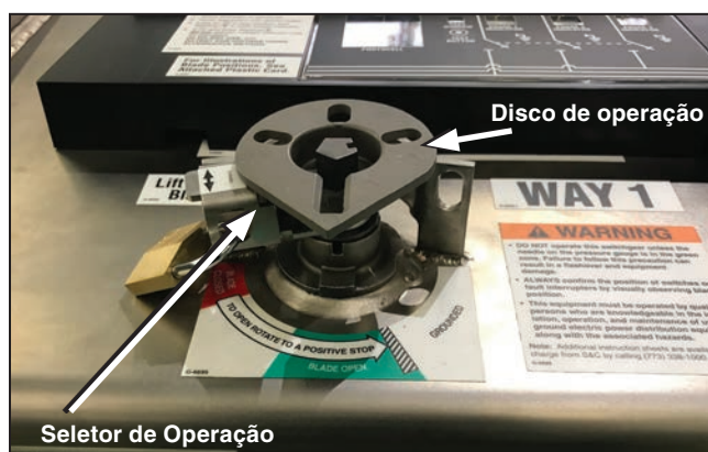
Figura 27. Bloqueio na posição Fechada.
