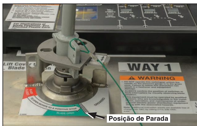
Figura 15. Gire totalmente até a posição de Parada.
