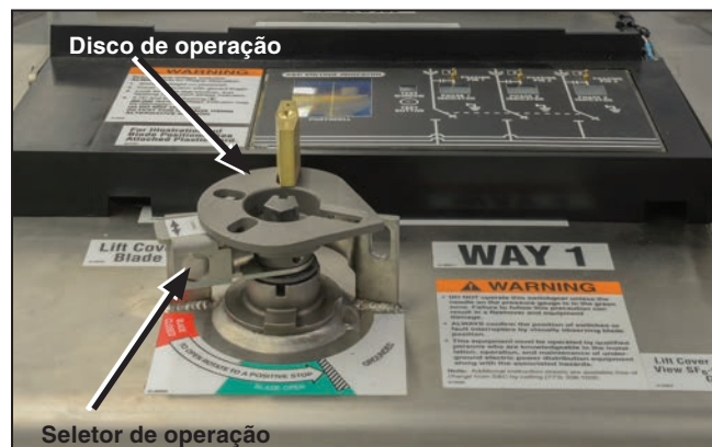
Figura 30. Bloqueio na posição Aterrada.
