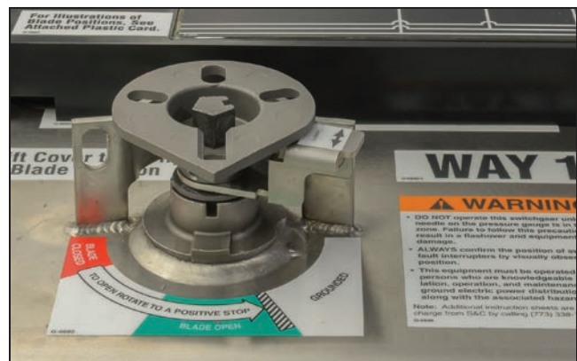
Figura 25. Interruptor de falta na posição Aberta.
