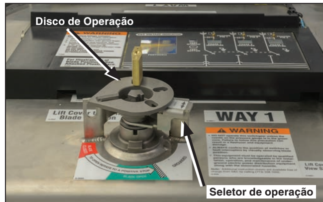
Figura 28. Bloqueio na posição Fechada.
