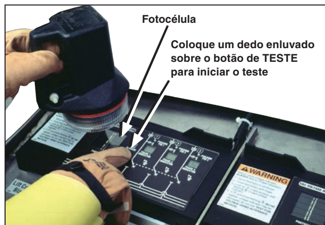
Figura 32. Teste o indicador de TENSÃO projetando a luz de uma lanterna sobre a fotocélula e cobrindo o botão de Teste com um dedo enluvado.
