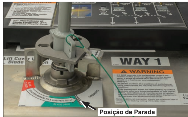
Figura 24. Gire completamente até a posição de Parada.
