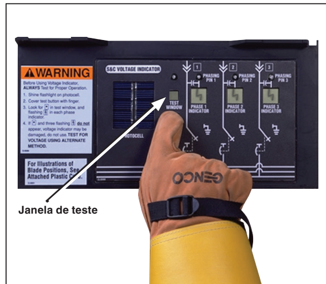
Figura 34. A ausência do ponto na janela de Teste indica que o indicador de TENSÃO não está em modo Teste.
