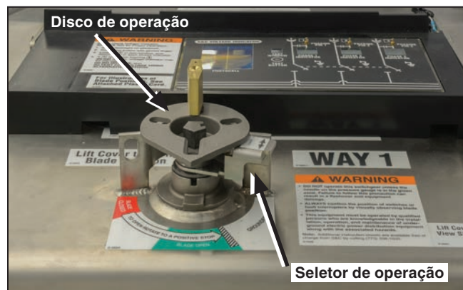
Figura 29. Bloqueio na posição Aberta.
