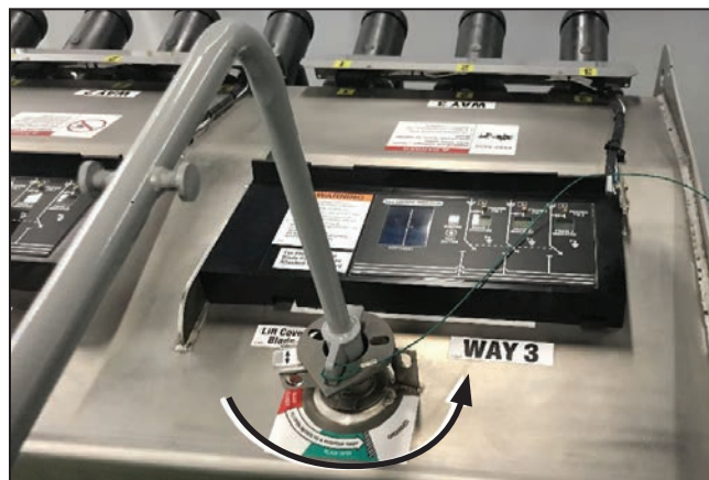
Figura 17. Operación de la posición Abierto a la Posición de Aterrizado.
