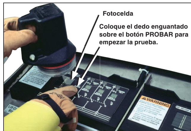
Figura 32. Pruebe el botón del indicador de TENSIÓN haciendo brillar una linterna sobre la fotocelda y cubriendo con un dedo enguantado el botón de Prueba.
