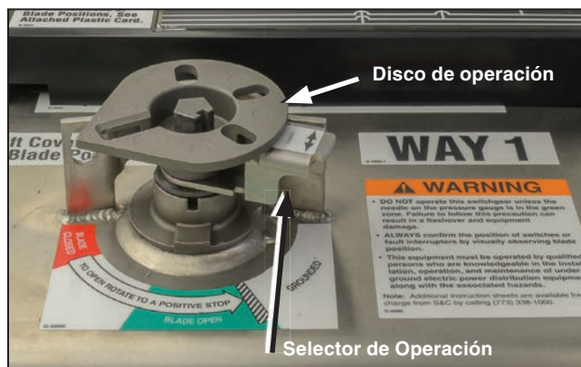
Figura 11. En la posición extrema derecha, el selector de OPERACIÓN permite la operación entre las posiciones Cerrado y Abierto.
