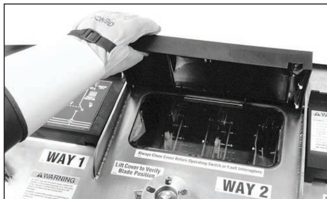
Figura 9. Levante la cubierta de la ventana de inspección para observar la posición de las cuchillas del seccionador o del interruptor de falla.
