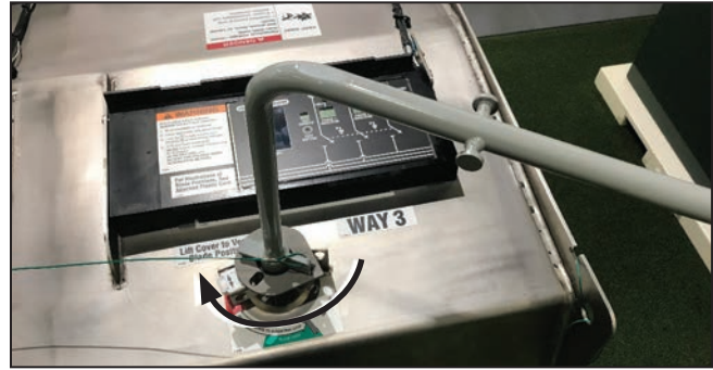
Figura 19. Operación de la posición de Aterrizado a la posición Abierto.
