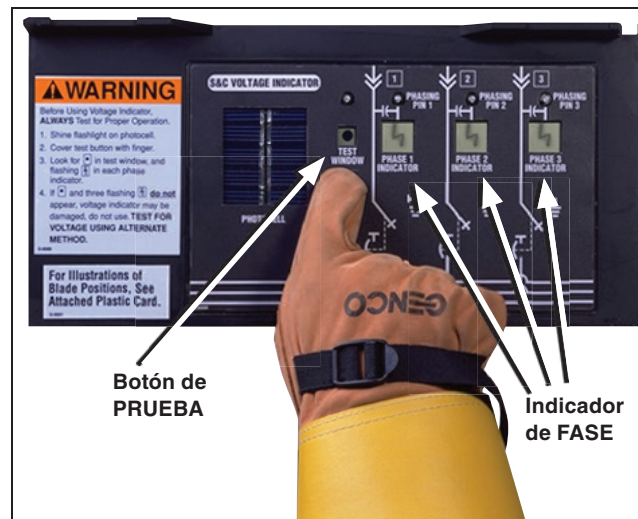
Figura 33. La presencia de un punto en la ventana de Prueba indica que el indicador de TENSIÓN se encuentra en el modo de Prueba.
