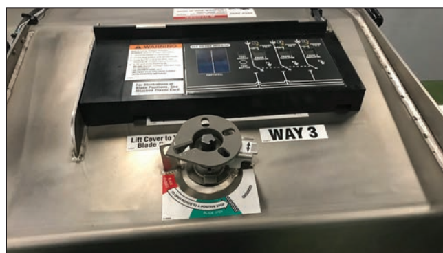
Figura 22. El interruptor seccionador de carga o el interruptor de fallas en la posición Cerrado.
