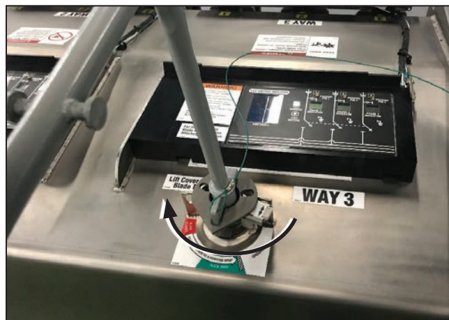
Figura 21. Cierre del interruptor seccionador de carga o el interruptor de fallas.
