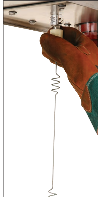
Figura 19. Antena tipo látigo enganchada al conector en la parte inferior de la base del interruptor de fallas IntelliRupter.
