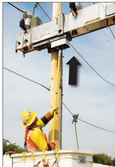
Figura 17. Inserción del módulo en la celda de la base.
