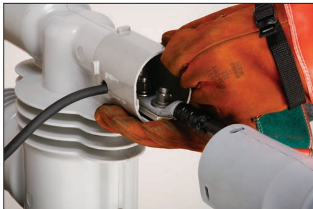
Figura 11. Instalación de la tapa de la zapata terminal superior.
