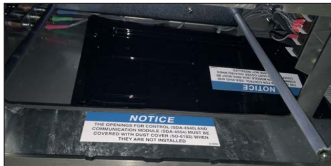
Figura 6. Colocando la cubierta para polvo en el estante en la celda.
