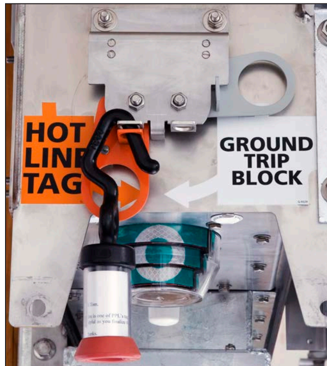
Figura 29. "Indicación" de la etiqueta de línea viva aplicada manualmente.
