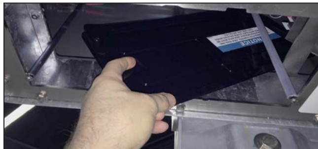
Figura 5. Colocando la cubierta para polvo en la celda del módulo.
