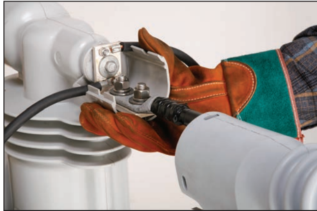
Figura 10. Instalación de la tapa de la zapata terminal inferior.
