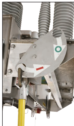
Figura 32. Cierre de la palanca operativa de la cuchilla.
