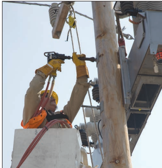
Figura 9. Apriete los tornillos pasantes. Asegúrese que la arandela plana quede entre la cabeza del tornillo y la ménsula de montaje.
