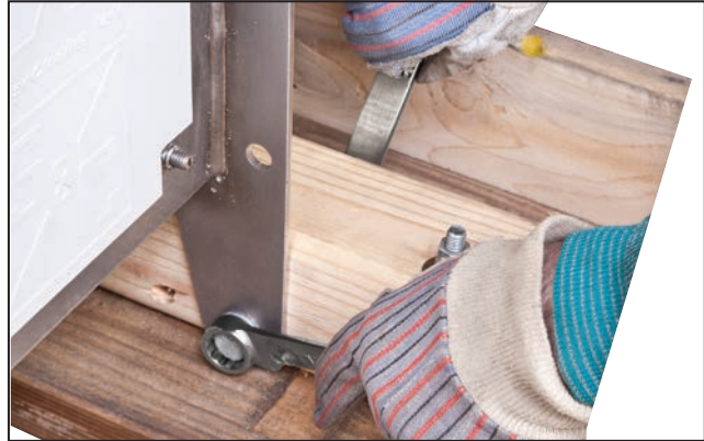
Figura 3. Desatornillando un interruptor de fallas de los soportes de embarque.
