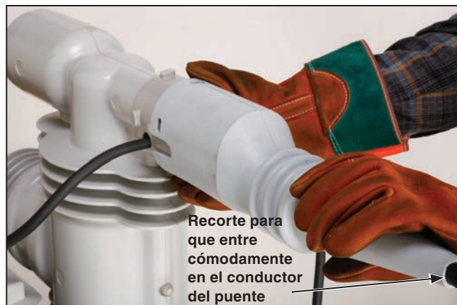
Figura 12. Instalación de la tapa de la toma.
