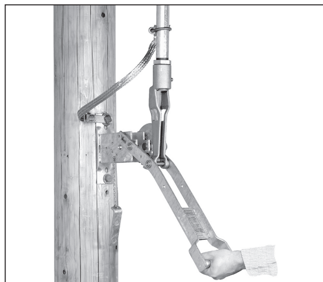
Figura 23. Verificaciones de que se ha eliminado el juego en el varillaje de operación.
