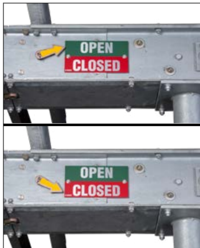
Figura 41. El indicador de POSICIÓN DEL INTERRUPTOR en posición Abierta (arriba). El indicador de POSICIÓN DEL INTERRUPTOR en la posición Cerrado (abajo).
