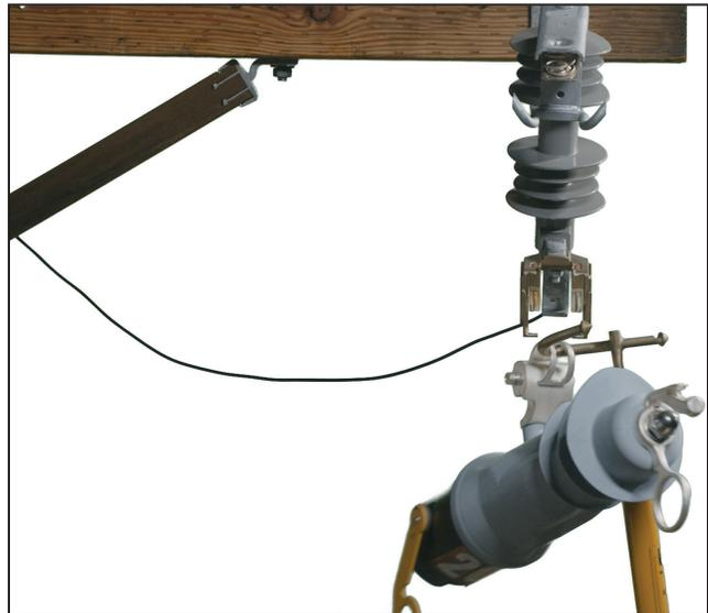
Figura 9. Utilizando una herramienta Talon durante la instalación.
