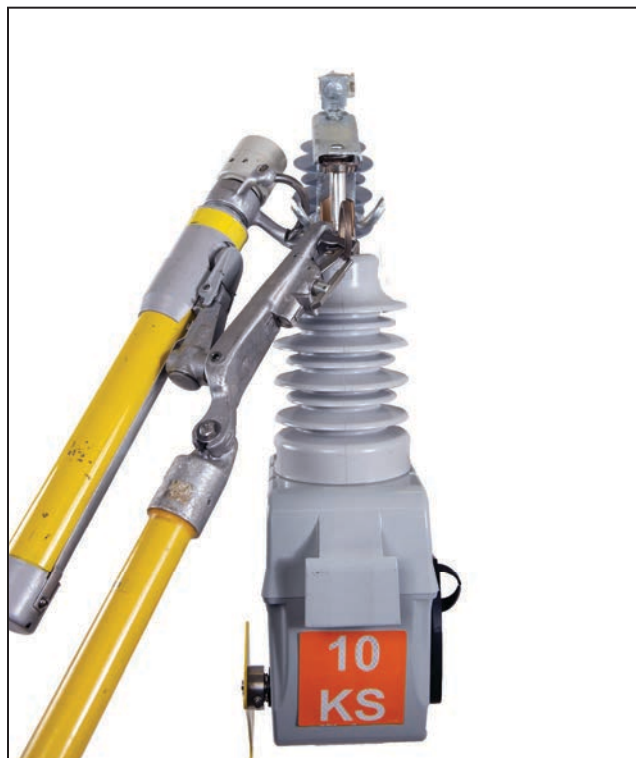
Figura 26. Un acercamiento de sujeción incorrecto.
