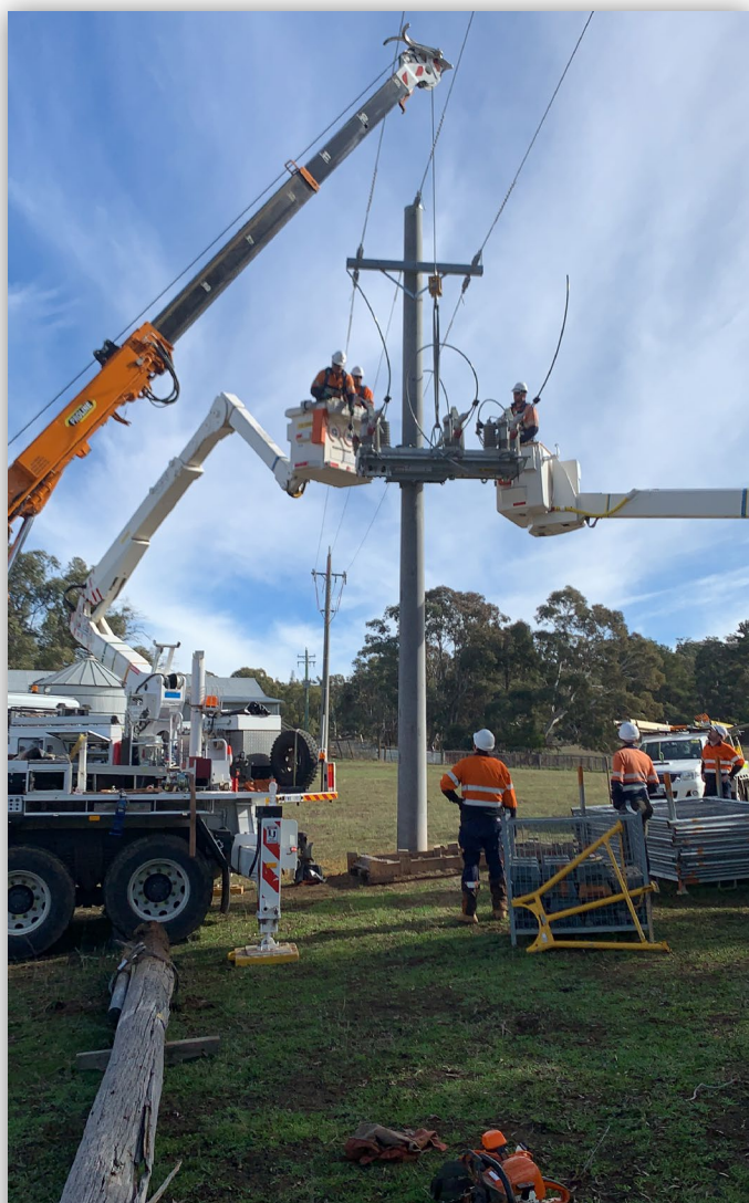
FIGURA 1. Instalação de um interruptor de falta IntelliRupter® com o novo algoritmo de faltas à terra de alta impedância.
