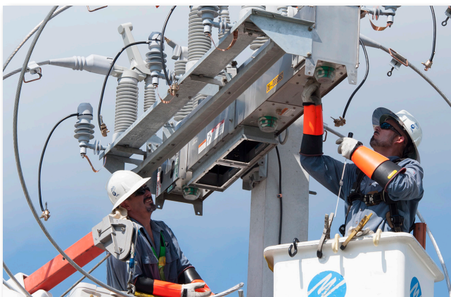
Um interruptor de falta IntelliRupter sendo instalado.
