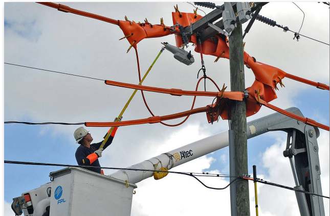
Equipe da FPL instalando religadores TripSaver II.
