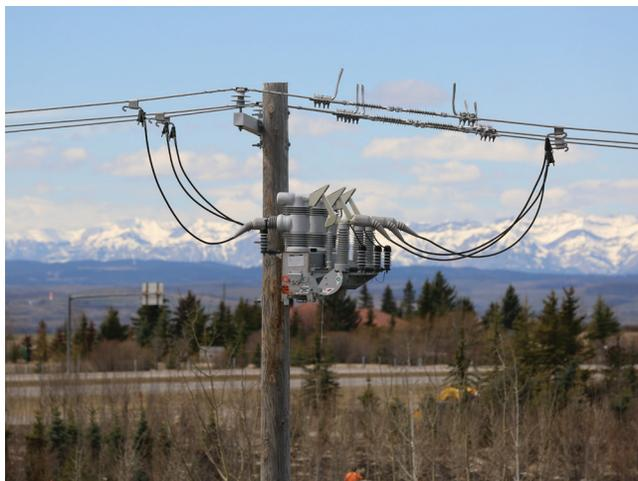
Figura 1. Um dos Interruptores de Falta IntelliRupter® PulseCloser® da S&C instalados pela ENMAX para tratar das interrupções momentâneas.
