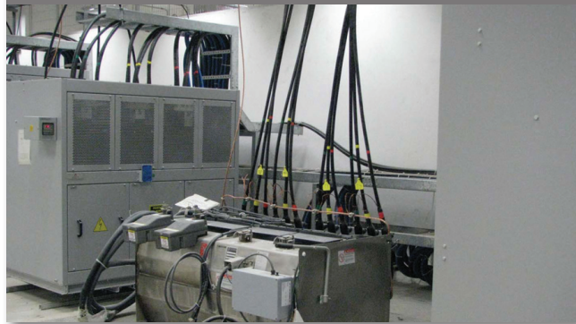
Instalación de un Interruptor de Distribución Subterránea Vista con Supervisión Remota.
